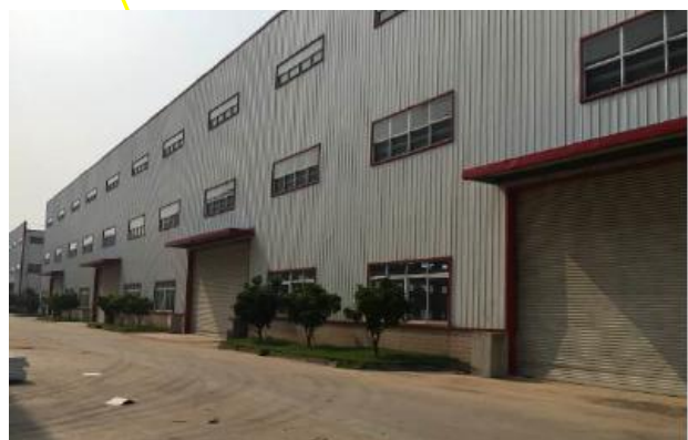
南面 高明基业冷轧有限公司厂房
