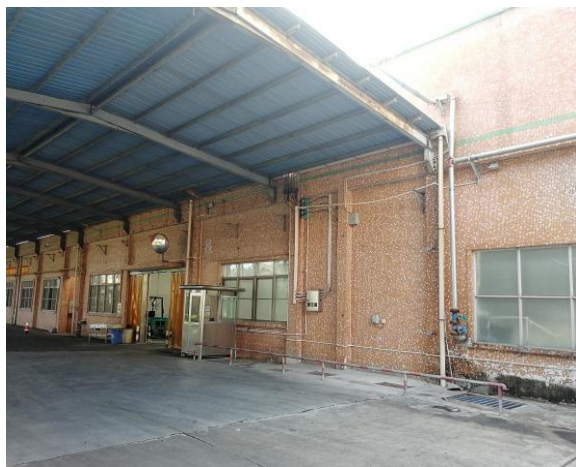
项目东侧 佛山市高明鸿鹰食品有限公司生产车间
