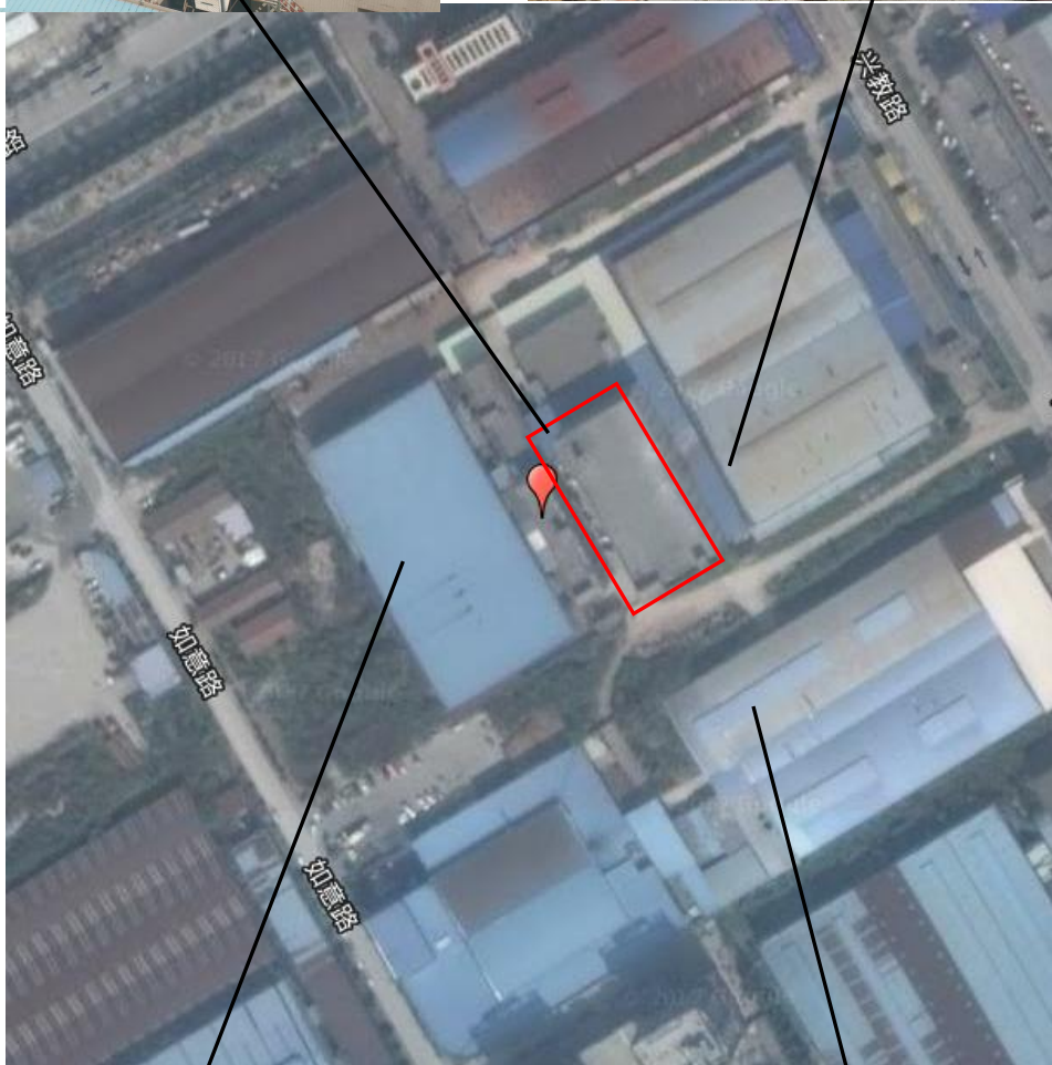
东面 捷丰裕金属制品有限公司厂房
