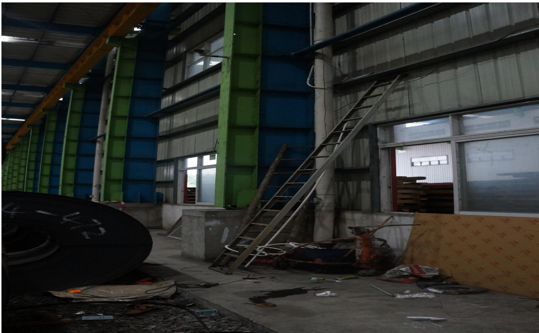
图二 事故现场情况
