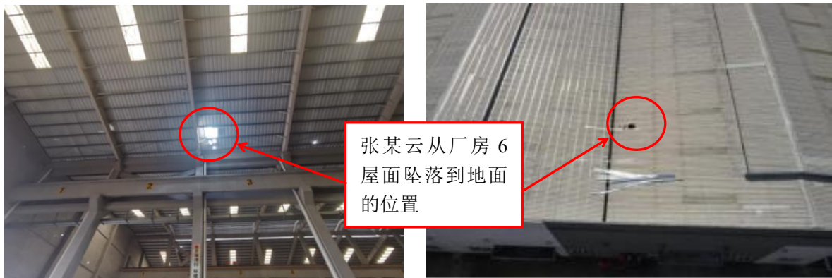
图二 事故现场情况
