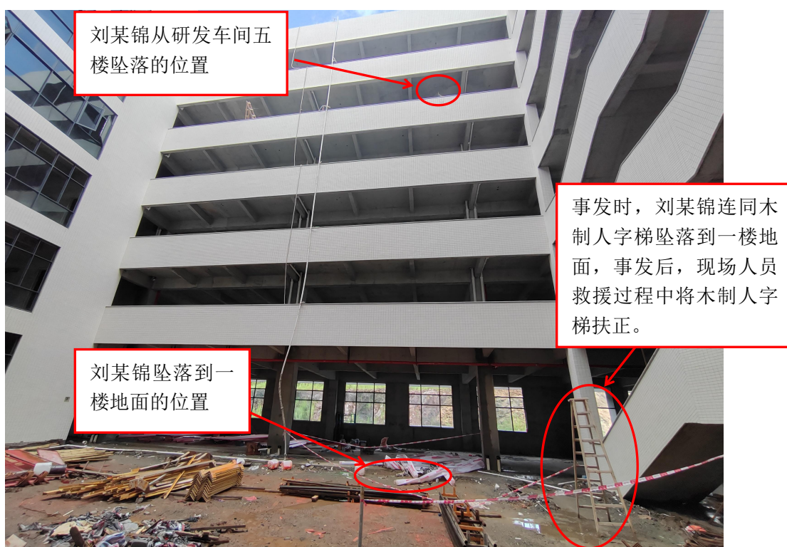
图 1 事故现场情况
