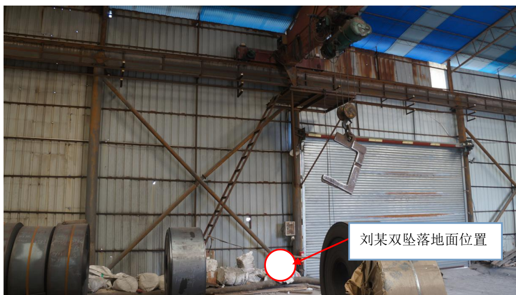
图 1 事故现场情况
