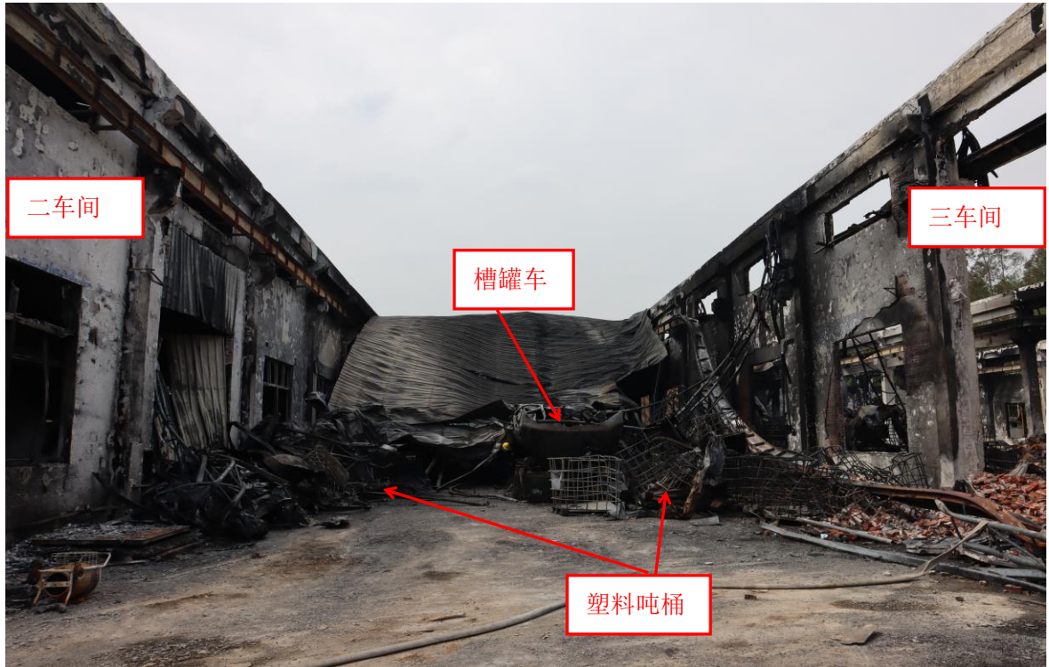
图二 火灾事故现场情况
