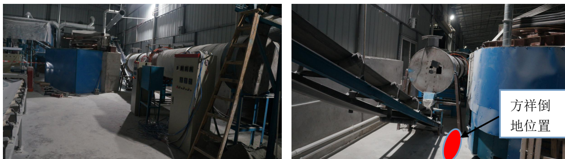
图二 发生事故的烘干机设备
