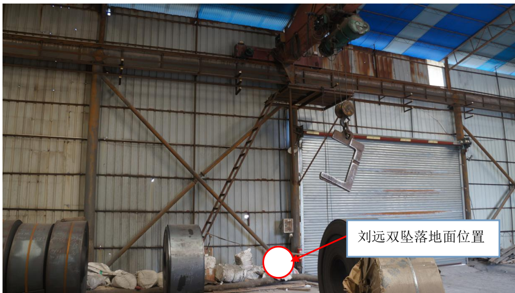
图 1 事故现场情况
