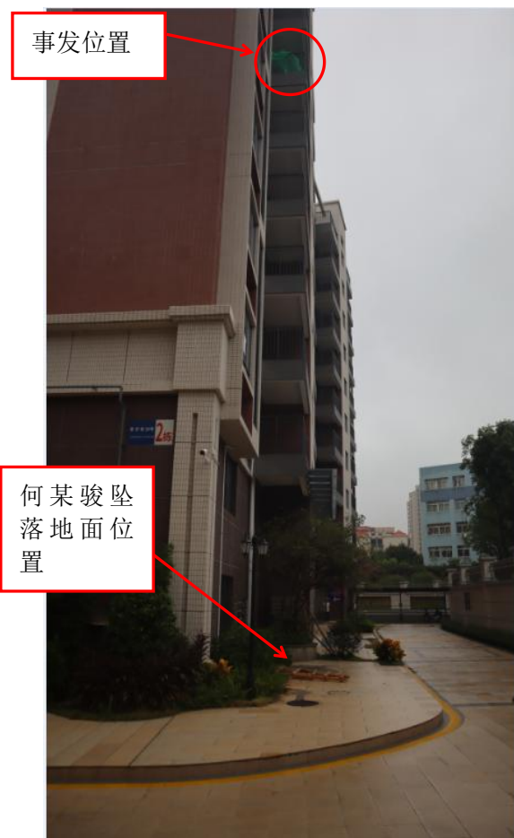
图一 事故现场情况
