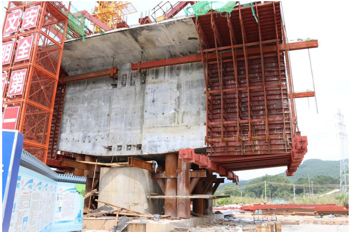
图一 27#桥墩整体情况
