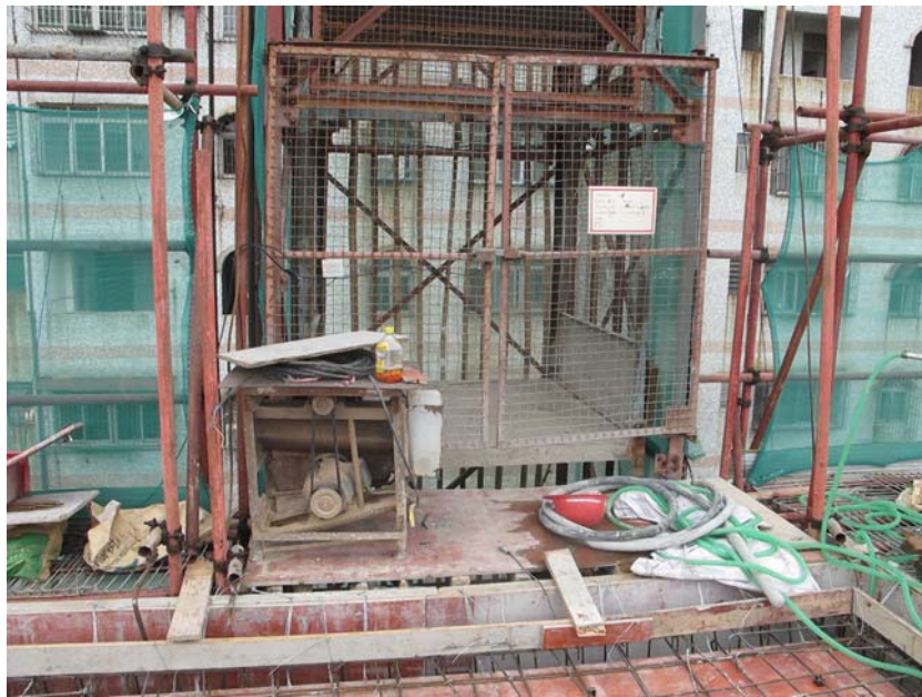
图二 顺满楼 6 层卸料平台与提升机情况
