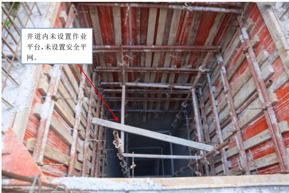
图二 电梯井道内第四层作业现场情况
