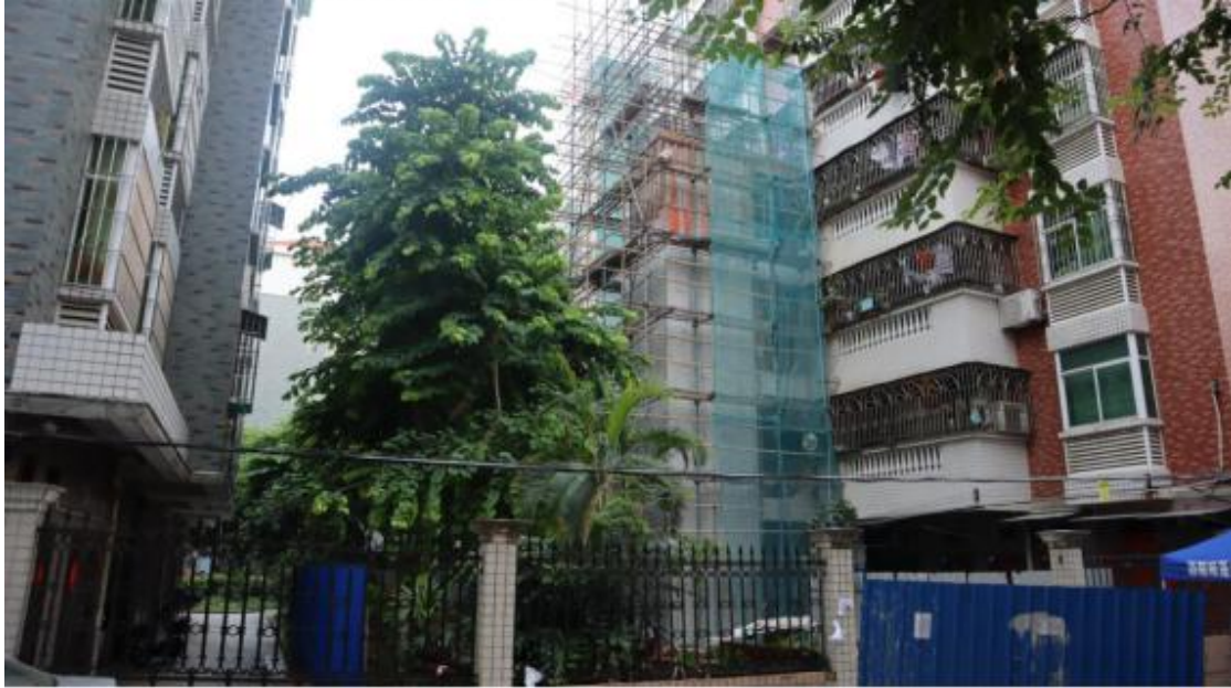
图一 华虹苑 2 座 4 梯加装电梯工程情况
